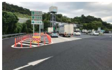
和歌山県 紀ノ川 SA 導流帯への駐車禁止
