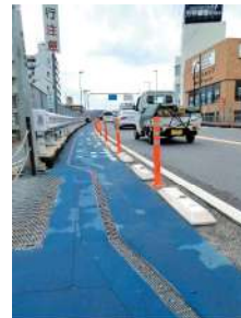
奈良県 国道168号 自転車専用レーン
