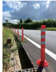
沖縄県今帰仁村 転落防止（側溝）
