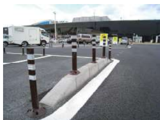
神奈川県 海老名 SA 段差注意喚起
