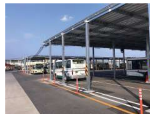
三重県 バス会社 車庫内 車両接触注意
