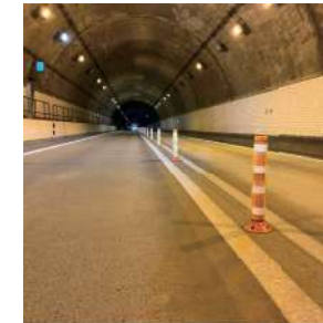
釜石自動車道 中央分離帯
