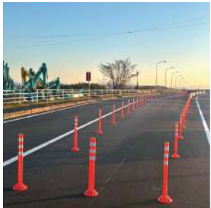
三重県 国道368号 中央分離の進入禁止
