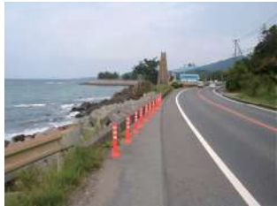
熊本県天草市 転落防止（防波堤）
