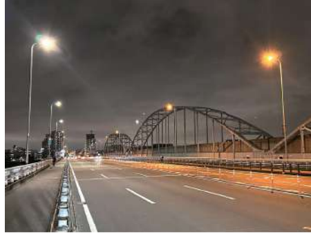
神奈川県 国道1号 中央分離帯
