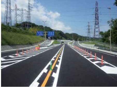
群馬県 国道353号 車線分離・合流注意
