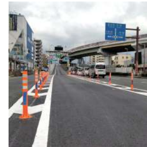
阪神高速14号松原線 一般道との車線分離
