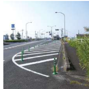
宮崎県 国道10号 路肩の駐車禁止
