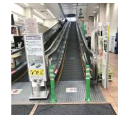
愛知県 ホームセンター内 オートスロープ前注意喚起
